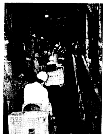
写真-5 掘削状況
